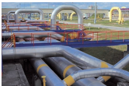
Obr. 2 Potrubný dvor kompresorovej stanice
