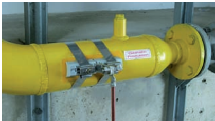
Pripojenie kovového potrubia k vyrovnaniu potenciálov pomocou atestovanej beziskrovej svorky Art. Nr. 540801 od výrobcu DEHN SE + Co KG
